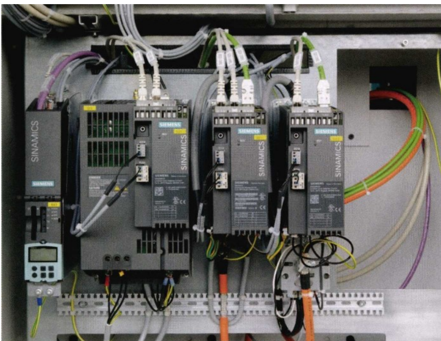
Geballte Lösung: Mit einem auf dem Sinamics S120-Antriebssystem aufbauenden Antriebskonzept kann der Antrieb aller Maschinentypen ohne Einbusse abgedeckt werden – eine wesentliche Vereinfachung für Konstruktion, Lagerhaltung und Wartung.
